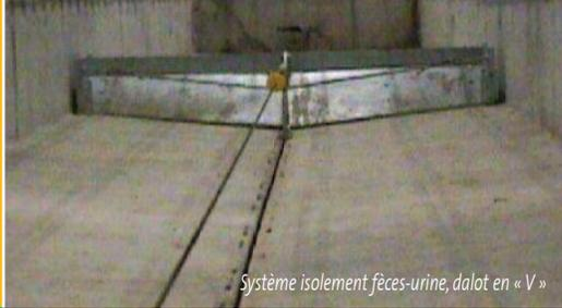
Système isolement fèces-urine, dalot en « V »
