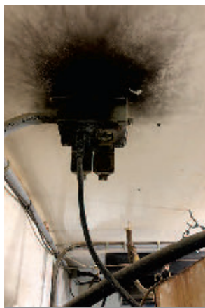
Début d'incendie en raison d'une surchauffe de la prise électrique causée par la corrosion.
