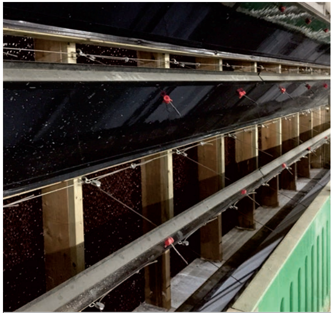
Entrée d'air par refroidissement d'air, dit cooling pad , associée à une ventilation tunnel modifiée dans une gestation (Ferme Saint-Dominique).
