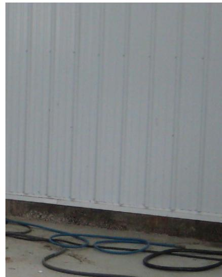
b) Moulure reposant sur le mur de fondation
